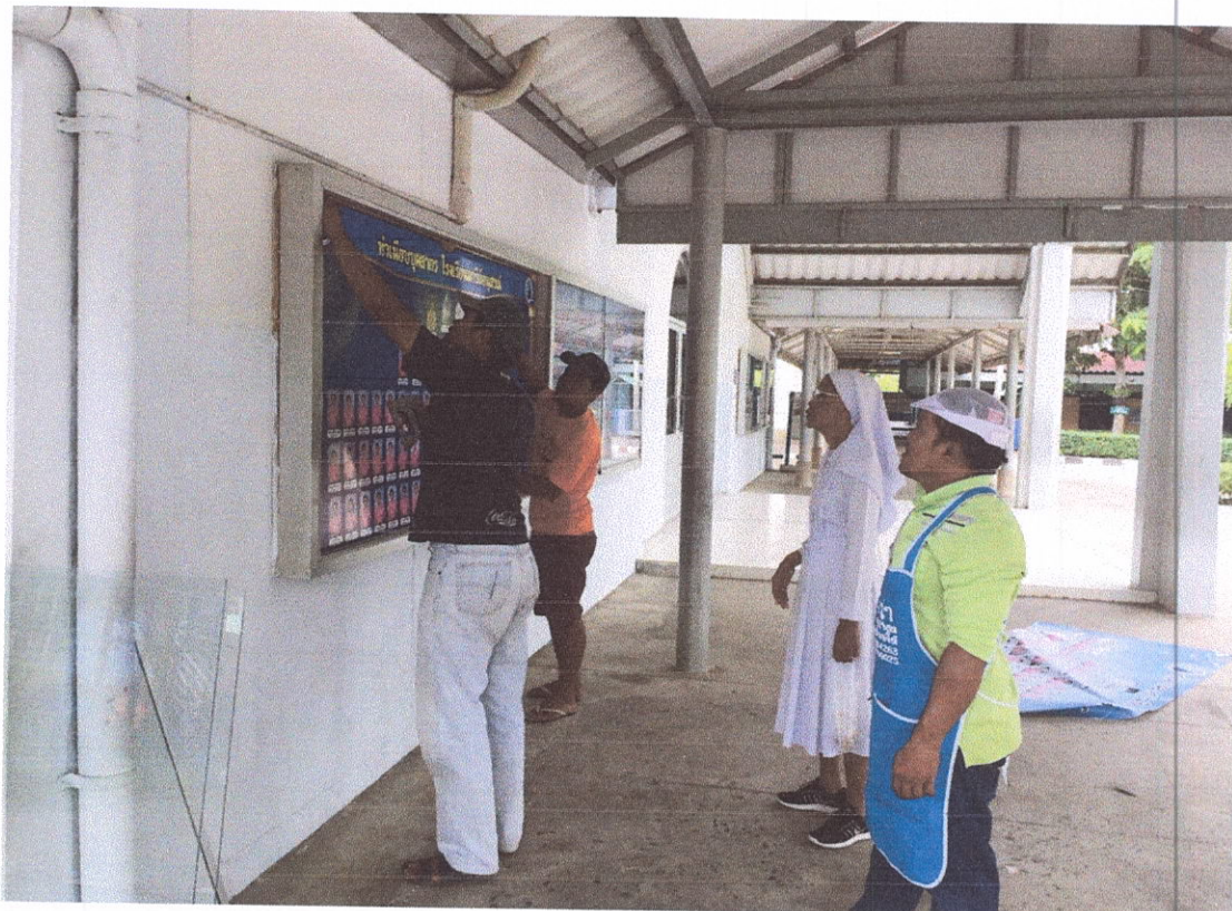
ติดตั้งบอร์ดทำเนียบครูและบุคลากรทางการศึกษา โรงเรียนมารีย์อนุสรณ์
