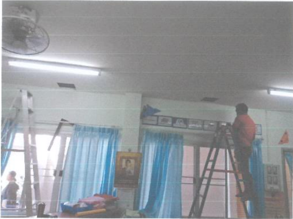
ติดตั้งเครื่องระบายอากาศในห้องเรียน
