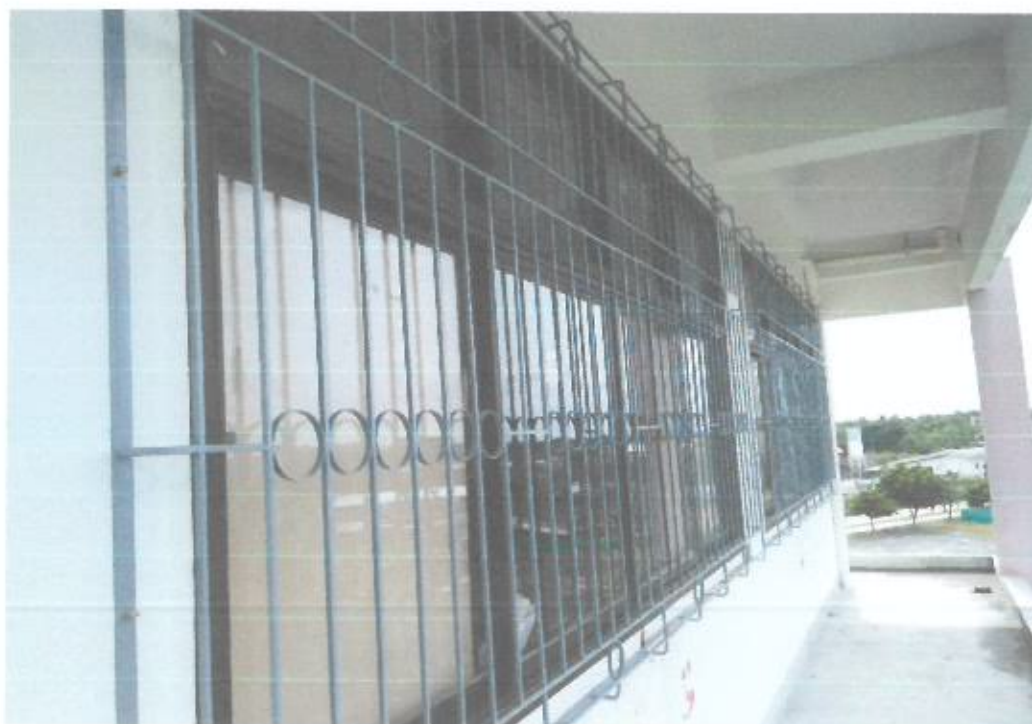
ติดตั้งเหล็กหน้าต่าง
