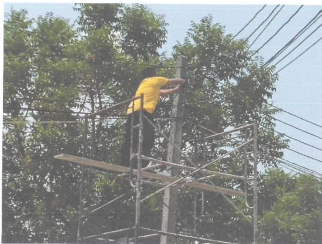
ซ่อมบำรุงสายไฟฟ้า
