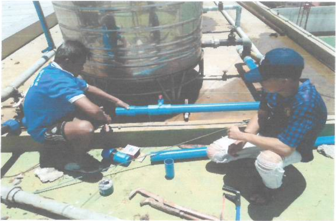
ซ่อมท่อน้ำ
