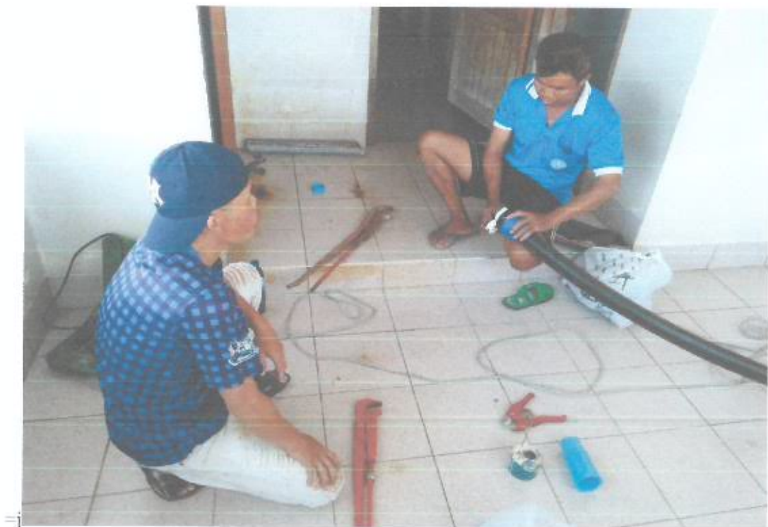
ซ่อมท่อน้ำ
