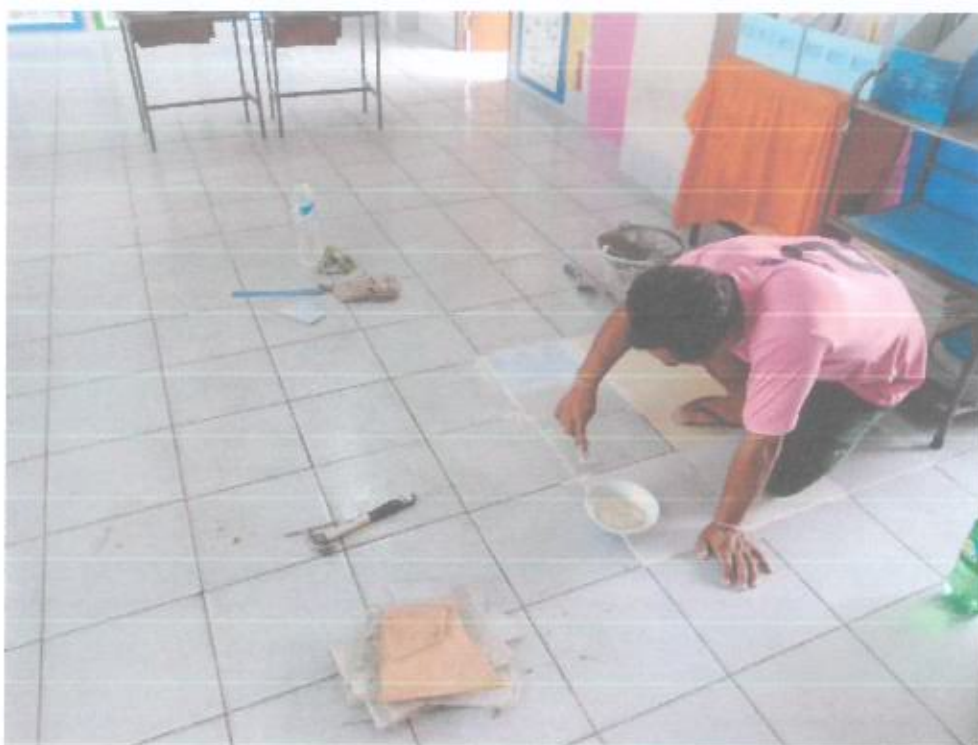
ซ่อมกระเบื้องพื้นห้องเรียน
