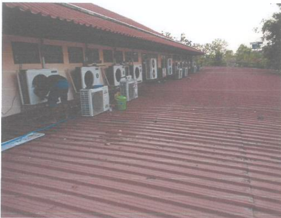
ล้างทำความสะอาดเครื่องปรับอากาศ
