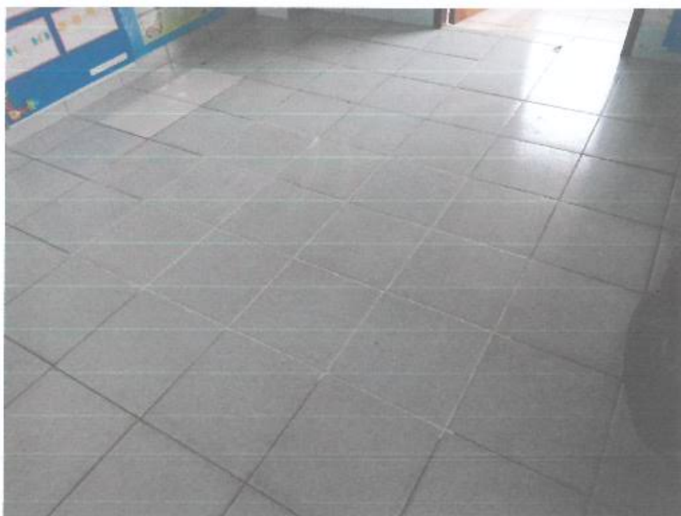
ซ่อมกระเบื้องพื้นห้องเรียน
