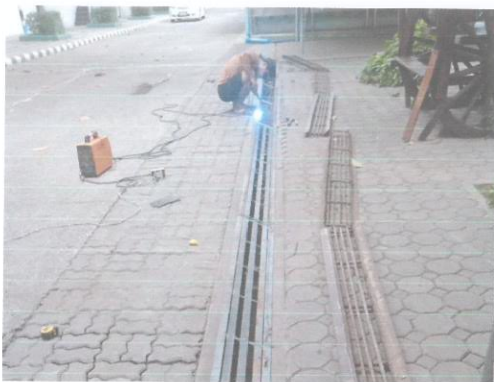
ซ่อมแซมตะแกรงร่องน้ำ
