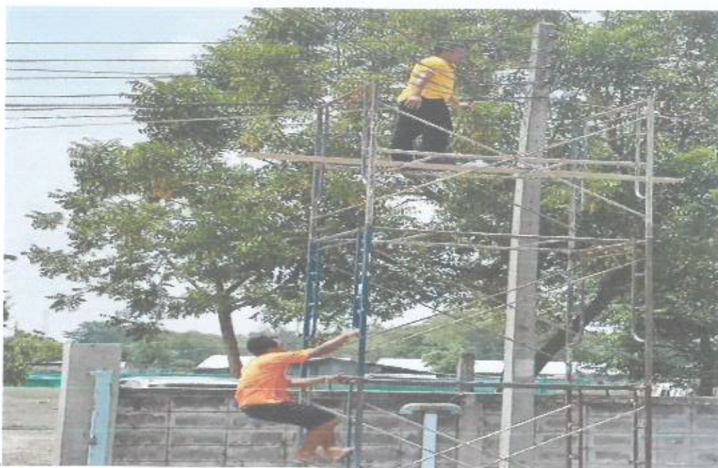
ซ่อมบำรุงสายไฟฟ้า
