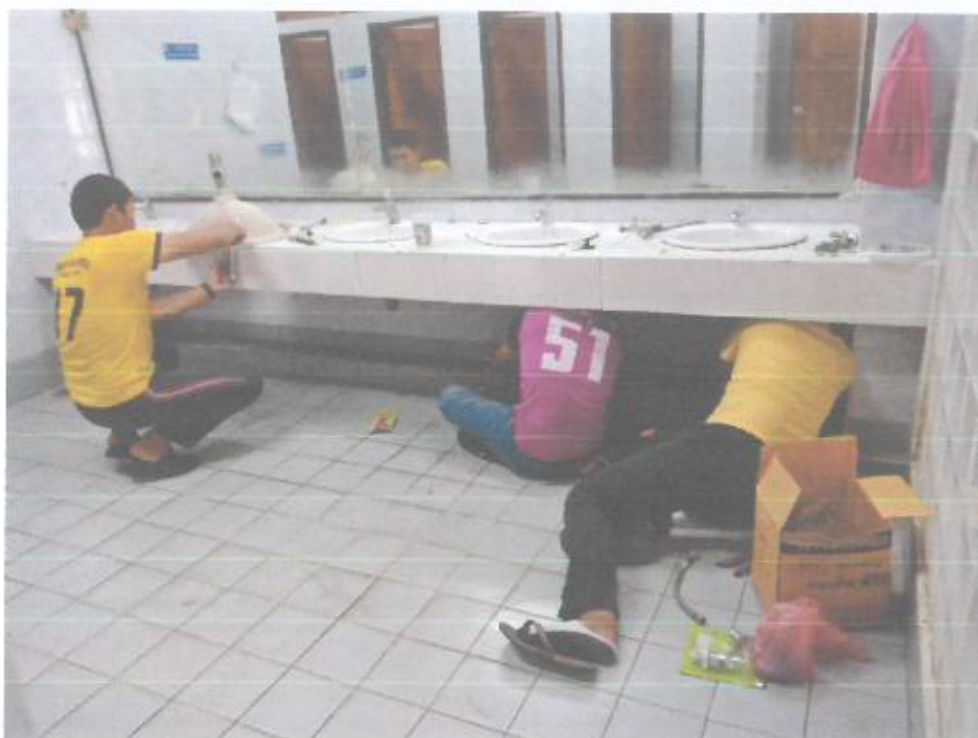
ซ่อมก๊อกน้ำ และท่อน้ำ
